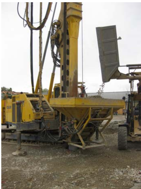
Rüttelstopfverdichtung
