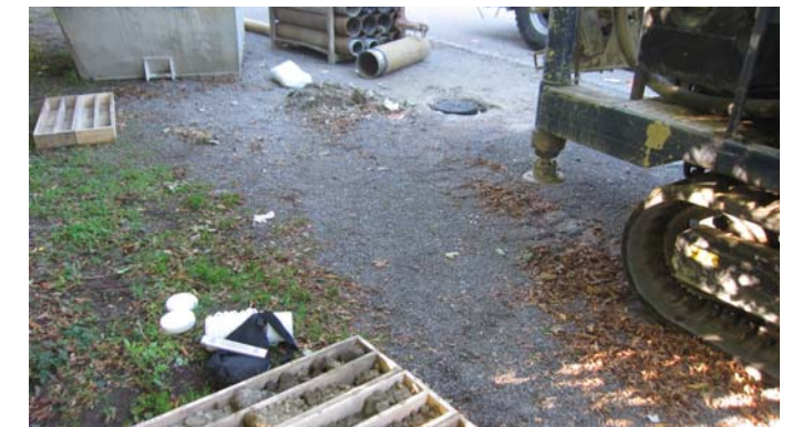
Bohransatzpunkt mit Unterflurausbau (Schacht)
