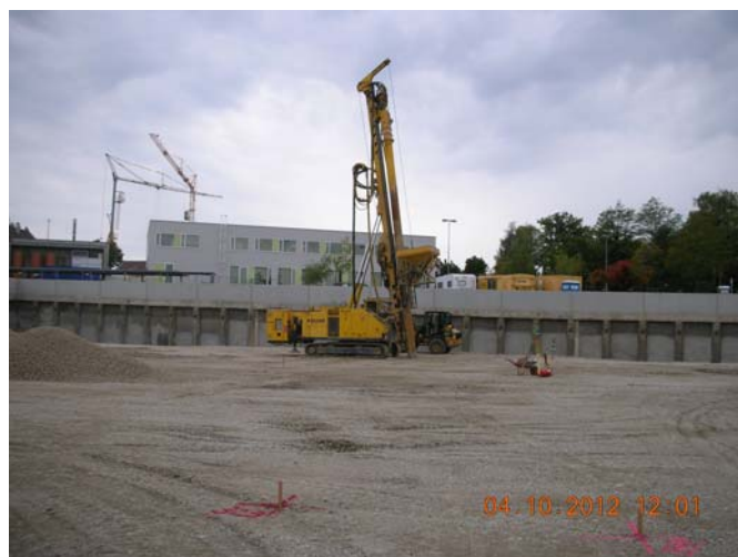
Rüttelstopfverdichtung
