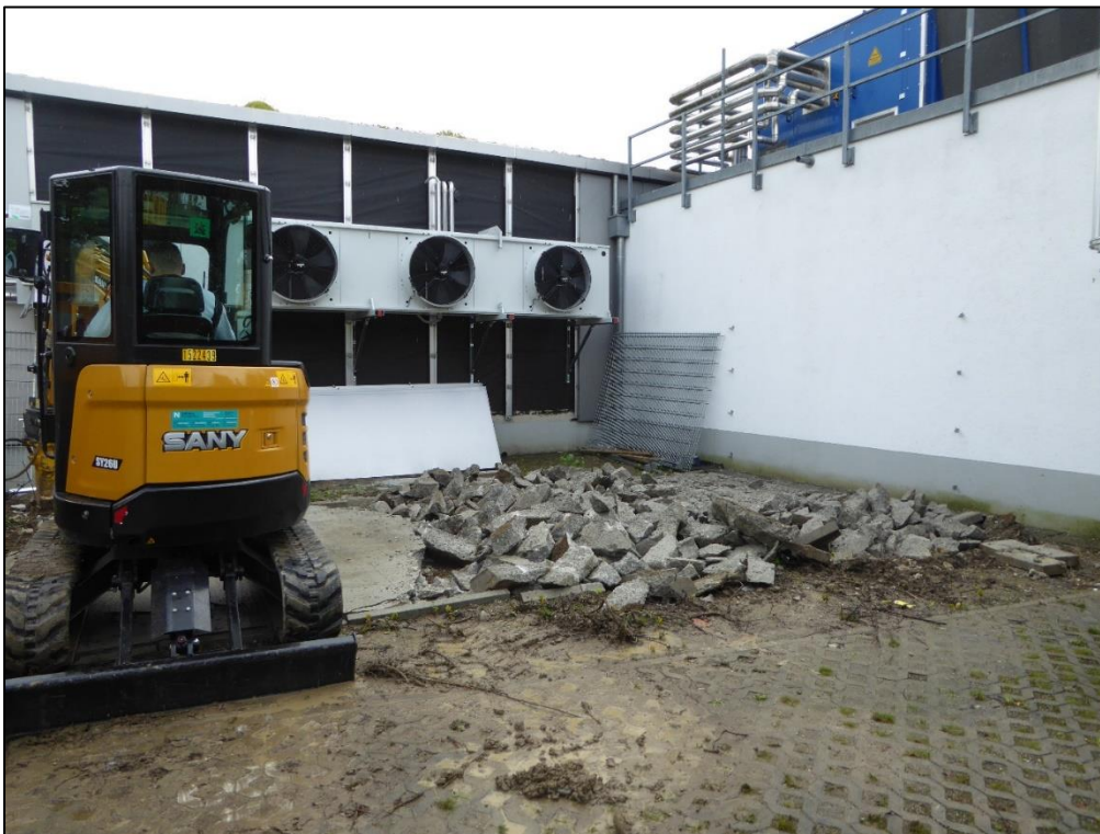
Abbildung 8: Rückbau der Bodenplatte am 29.05.2019
