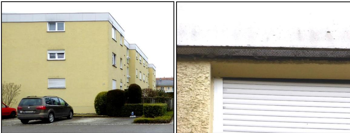
Abbildung 6: Häuserfassade mit Attika-Blechverkleidung (links); Schutzgitter als unterer Abschluss der Verkleidung (rechts)
